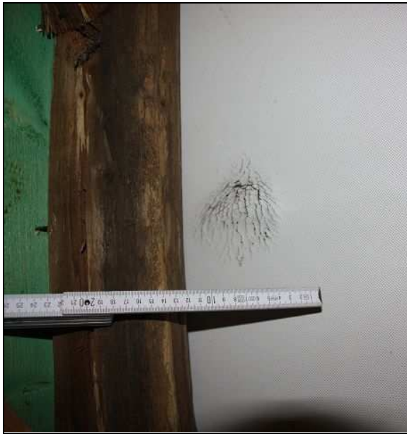
Abb. 7: Mechanische Überbeanspruchung
