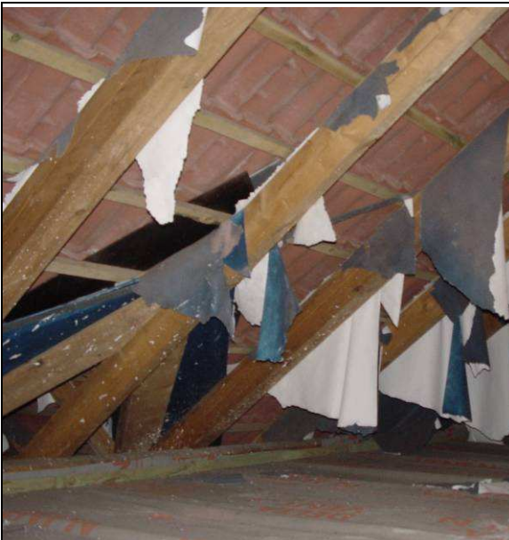
Abb. 3: Vollständiges Versagen der Funktions- und Trägerschicht
