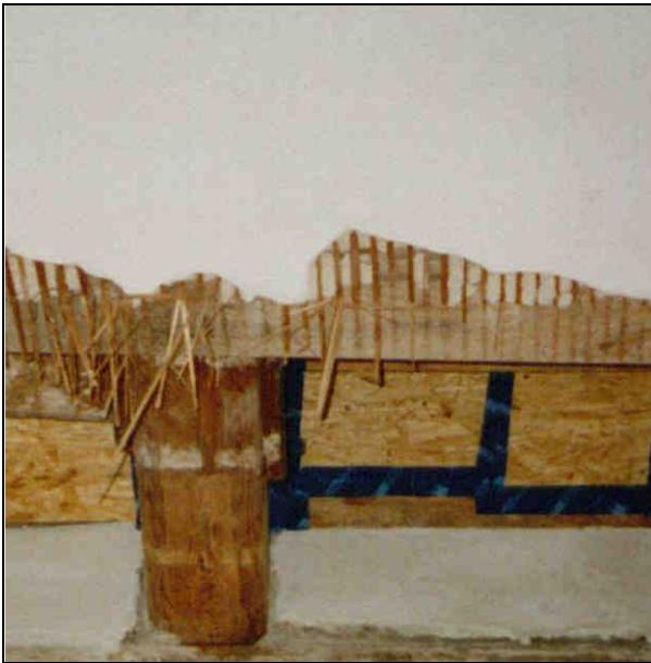
Abb. 71: Balkenköpfe der Holzbalkendecke ungeschädigt und tragfähig [Borsch-Laaks]
