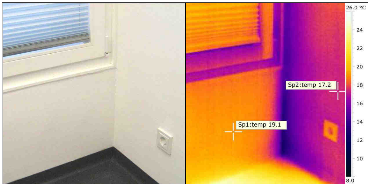
Abb. 58: Innenansicht der Treppenhauswand
