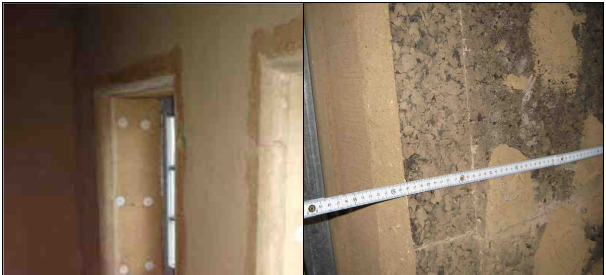
Abb. 40 + 41: Einbau der Holzweichfaser- bzw. Korkdämmplatten mit Dübeln
