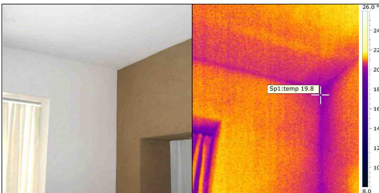
Abb. 60: Innenansicht der in die zweischalige Außenwand einbindenden Innenwand
