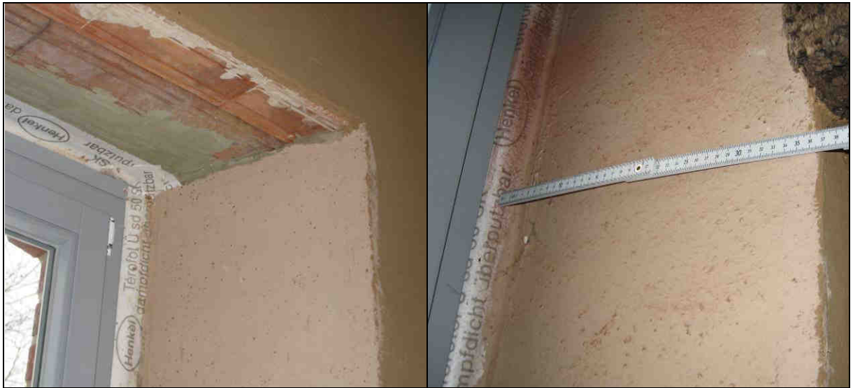
Abb. 38 + 39: Luftdichter Fensteranschluss bei einer diffusionsoffenen Innendämmung
