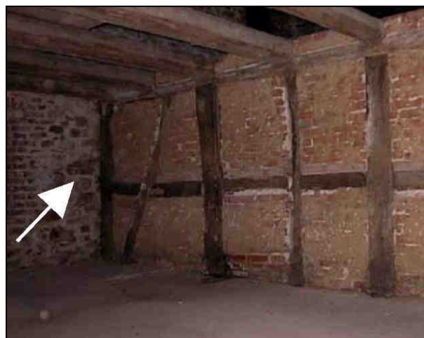
Abb. 66: Typisches Beispiel einer einbindenden Fachwerkwand
