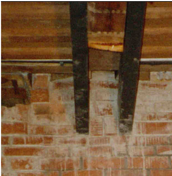
Abb. 73: Ersatz der durch Wasserschaden verfaulten Balkenköpfe durch Stahlzangenkonstruktionen [Borsch-Laaks]
