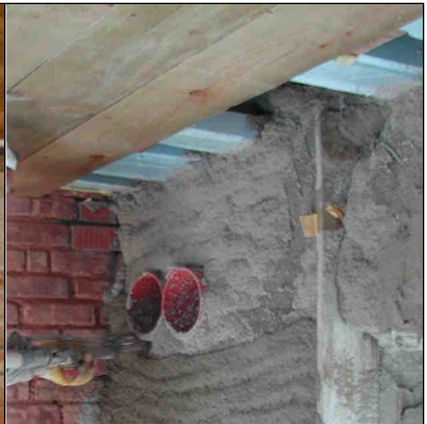
Abb. 74: Stahlträger gedämmt, Montage des Dämmputzes [Borsch-Laaks]
