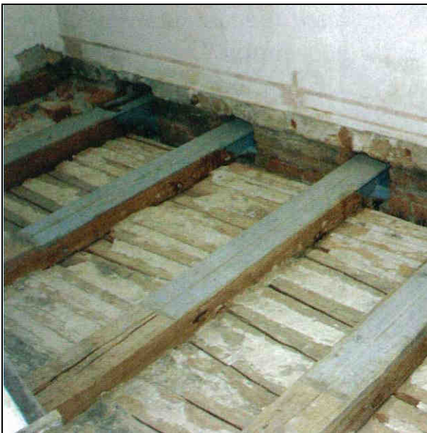
Abb. 75: Ersatz der nicht tragfähigen Balkenköpfe durch GFK-Träger [Flohr 2009]
