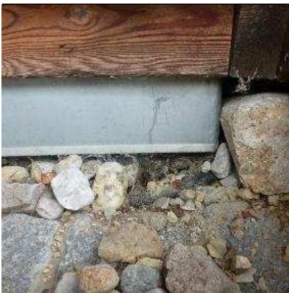
Abb. 67: Freigelegte Sockelabdichtung: Bitumenbahn unter der Blechbekleidung
