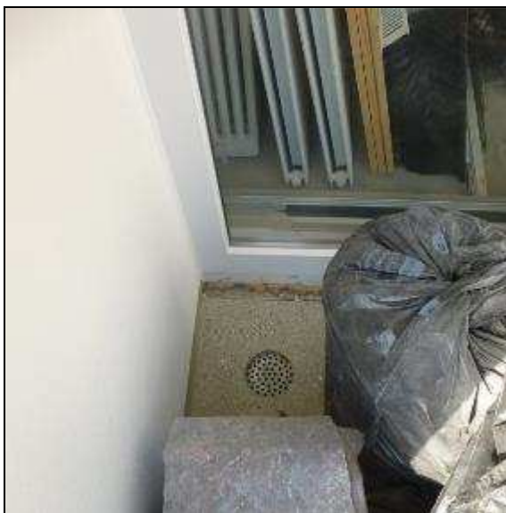
Abb. 79: Lage der Balkonentwässerung im obersten Geschoss
