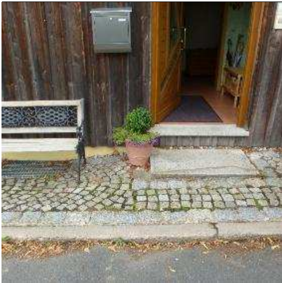
Abb. 55: Sockelanschluss neben der Hauseingangstür
