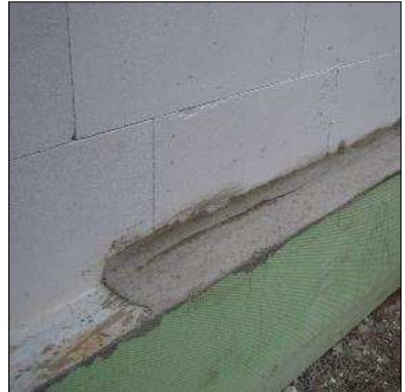
Abb. 52: Herstellen einer Mörtelhohlkehle
