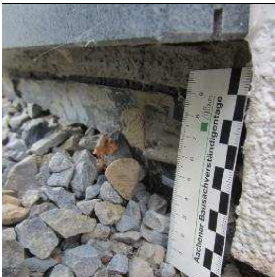
Abb. 75: Auskragender Schalungsstein
