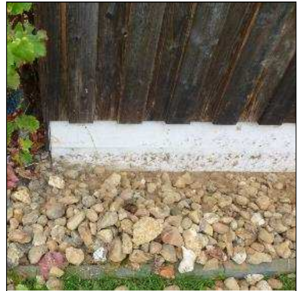
Abb. 70: Öffnungsstelle im Bereich der Gebäudeecke – Blick auf die Kalziumsilikatplatte
