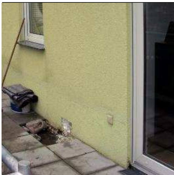
Abb. 43: Übersicht zum Sockelanschluss des WDVS
