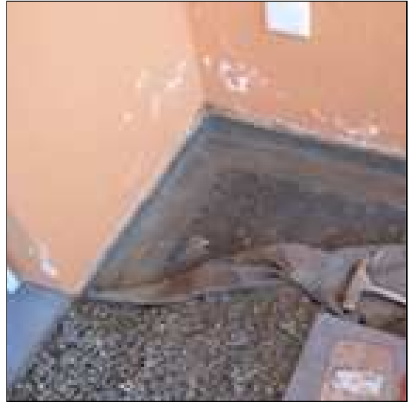
Abb. 30: Bahnenförmige Abdichtung mit Randanschlüssen aus mineralischer Dichtungsschlämme
