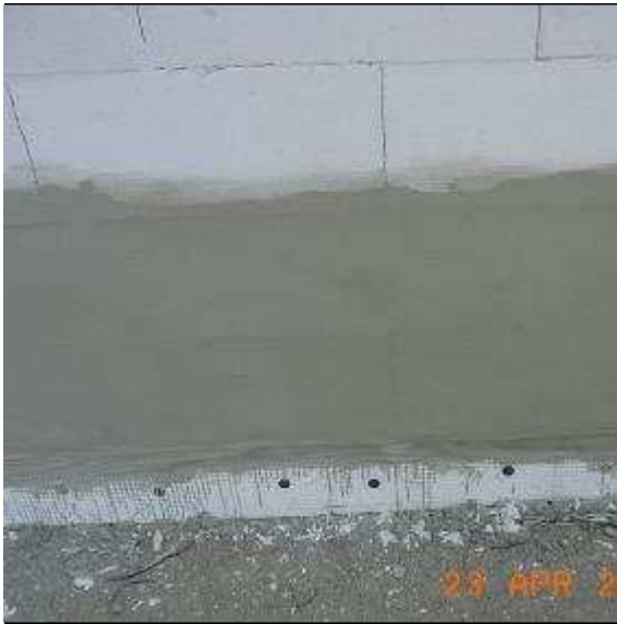
Abb. 17: Abdichtung des Sockelbereiches mit mineralischen Dichtungsschlämmen
