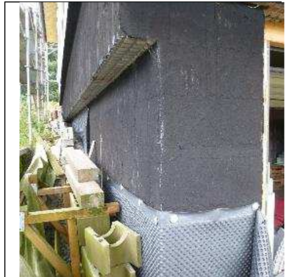
Abb. 22: Hangseitige Ansicht der abgedichteten und teilweise mit einer Noppenbahn abgedeckten Schalungsblöcke. Der Dickenversprung der Wand ist unterseitig noch nicht abgedichtet.
