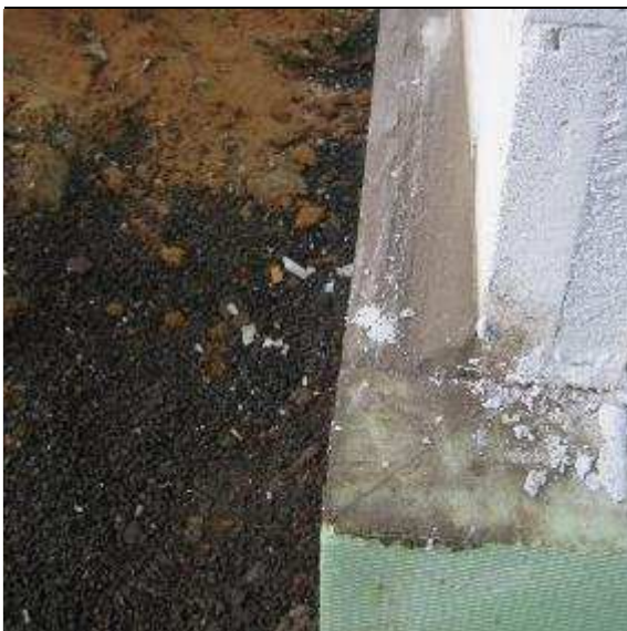
Abb. 53: Abschrägen des Anschlusses zwischen Bodenplatte und Außenwand
