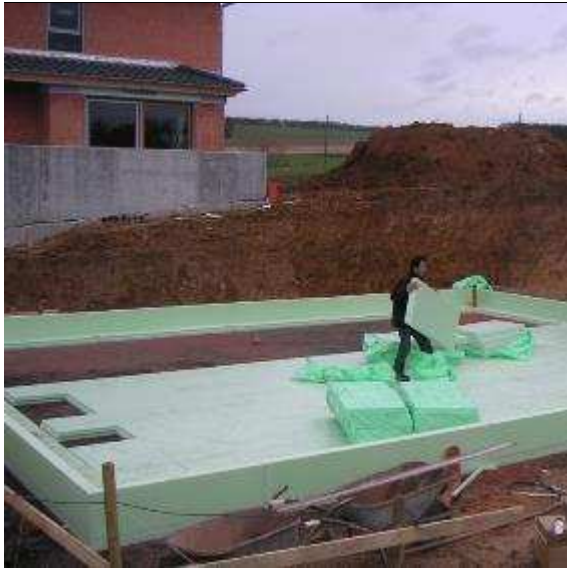
Abb. 51: Bodenplattendämmung
