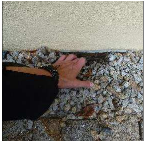
Abb. 56: Die Putzabdichtung des Sockels ist mit einer Noppenbahn abgedeckt
