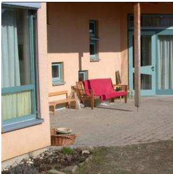
Abb. 33: Das Gelände schließt niveaugleich an das Gebäude an und ist nicht vom Gebäude weg geneigt.
