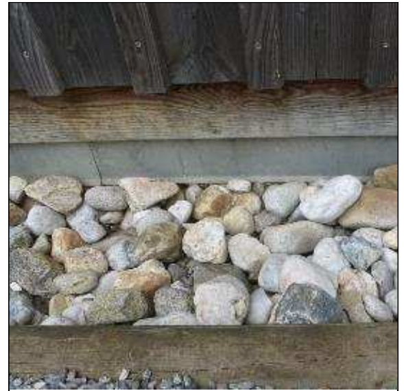
Abb. 66: Blech-Bekleidung über der Sockelabdichtung
