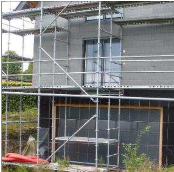
Abb. 21: Übersicht – das Gelände steigt zur Gebäuderückseite an
