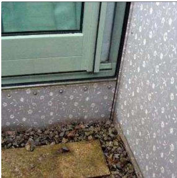
Abb. 39: Einbausituation neben der niveaugleichen Türschwelle
