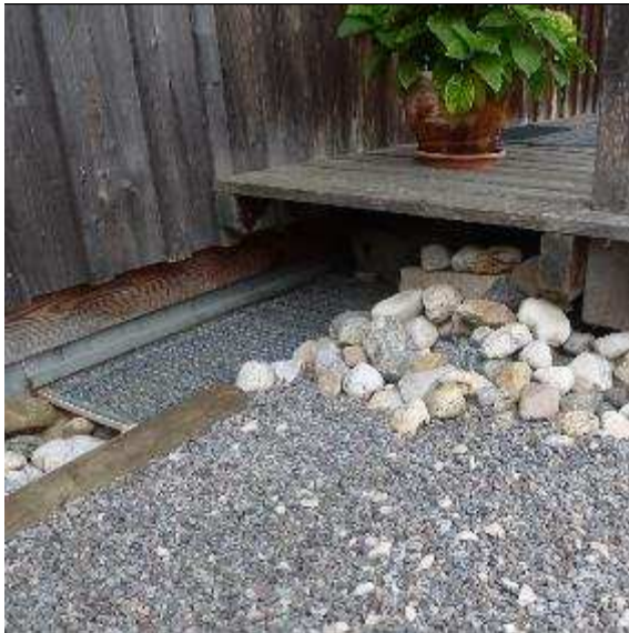
Abb. 65: Hauseingang mit Schwellenbereich oberhalb der Spritzwasserzone
