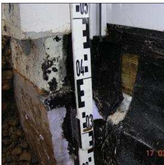
Abb. 27: Detailaufnahme im Bereich der Türschwelle
