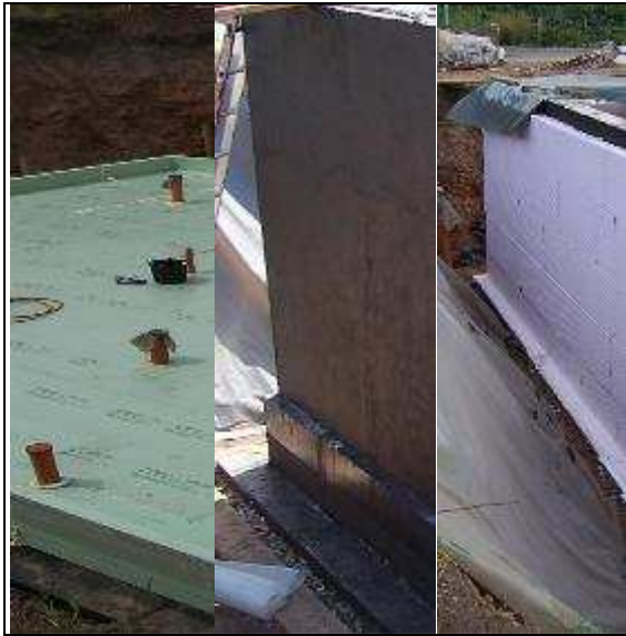
Abb. 49: Fotos zum Bauablauf
