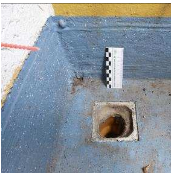
Abb. 83: Entwässerung der Balkone über Bodenabläufe
