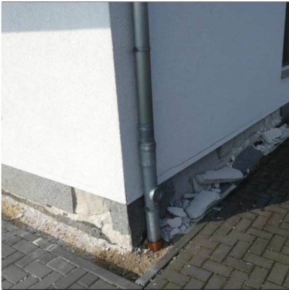
Abb. 11: Übersicht zum schadenbetroffenen Sockel
