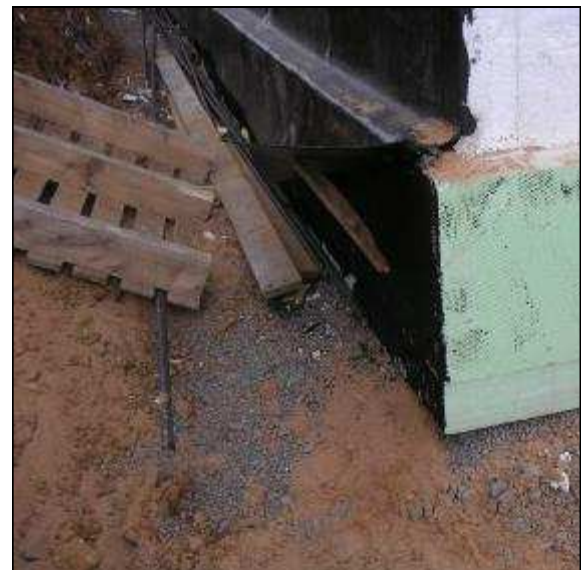
Abb. 54: KSK-Abdichtung entlang des Boden-Wand-Anchlusses
