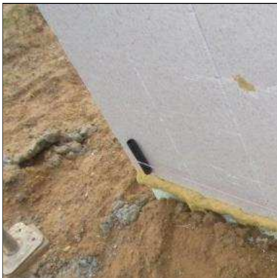
Abb. 15: Außenwand aus ausbetonierten Polystyrolblöcken als Abdichtungsuntergrund
