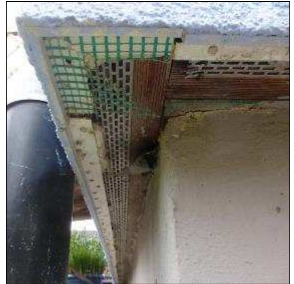
Abb. 62: Untersicht der hinterlüfteten Bekleidung
