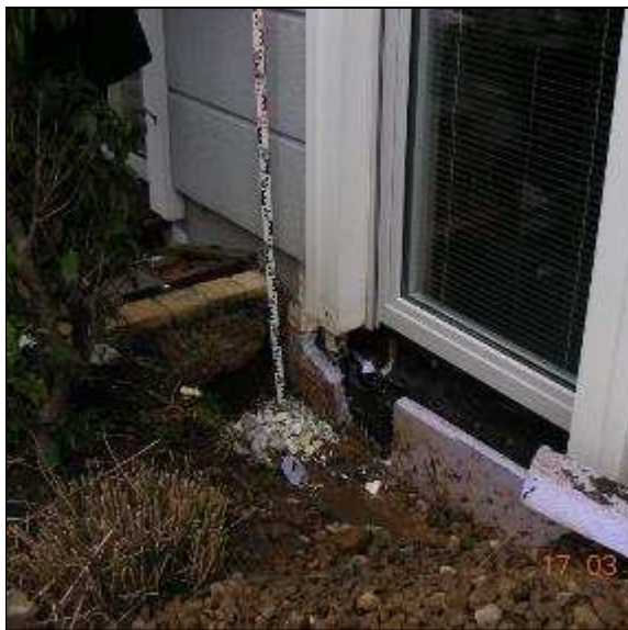
Abb. 25: Übersicht zum nachgebesserten Fassadensockel im Bereich der Türschwelle
