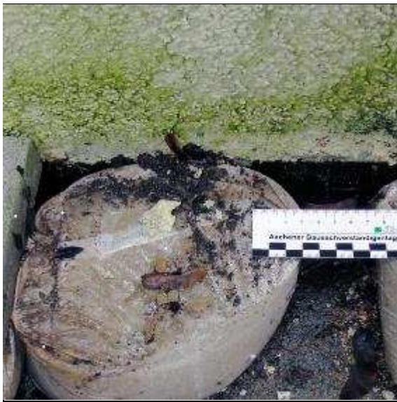
Abb. 45: KMB-Abdichtung als Instandsetzung des WDVS
