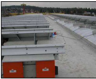
Dachfläche mit mittig angeordnetem Lichtband und seitlich aufgereihten Fotovoltaik-Anlagen
