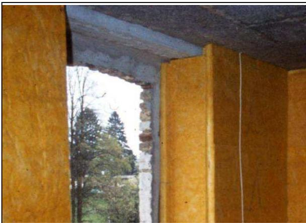
Bild 2: ausgeführtes Beispiel einer Innendämmung im Bereich der Fensterleibung bis hinter den Blendrahmen
