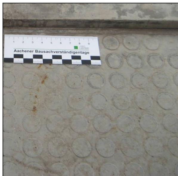
Abb. 3: Rutsicherheit durch in das Fertigteil integrierte Oberflächengestaltung
