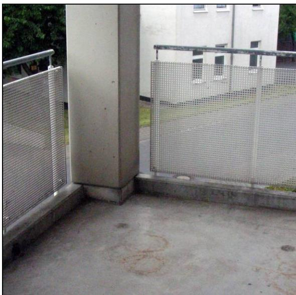
Abb. 2: Stahlbetonfertigteile ohne zusätzliche Abdichtung als Balkonbodenplatte
