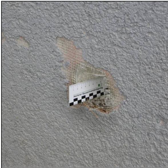
Abb. 5: Im Eingangsbereich durch Vandalismus beschädigtes Wärmedämmverbundsystem
