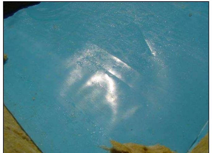
Abbildung 14 und 15: Probestelle mit Tauwasser auf der Dampfsperffolie
