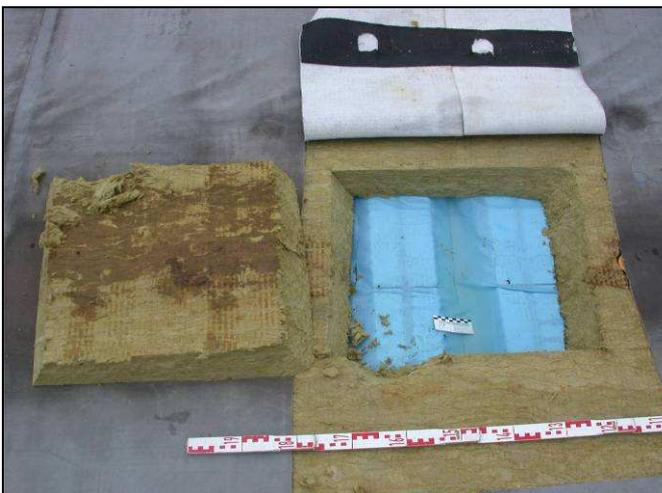
Abbildung 18, 19 und 20: Erheblich durchfeuchteter Dämmstoff über einer Tiefsicke, in der Wasser steht.
