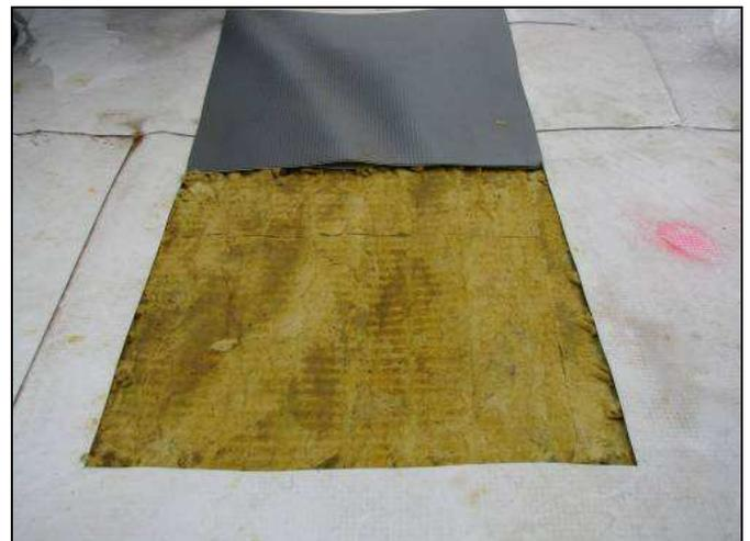
Abbildung 22: Öffnungsstelle 3 mit oberflächlich feuchter, aber insgesamt trockener (0,7 Masse-%) Dämmung
