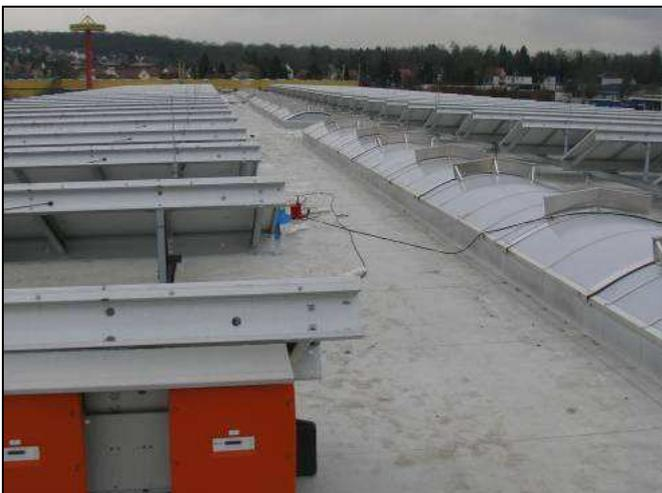
Abbildung 21: Dachfläche mit mittig angeordnetem Lichtband und seitlich aufgereihten Fotovoltaik-Anlagen.
