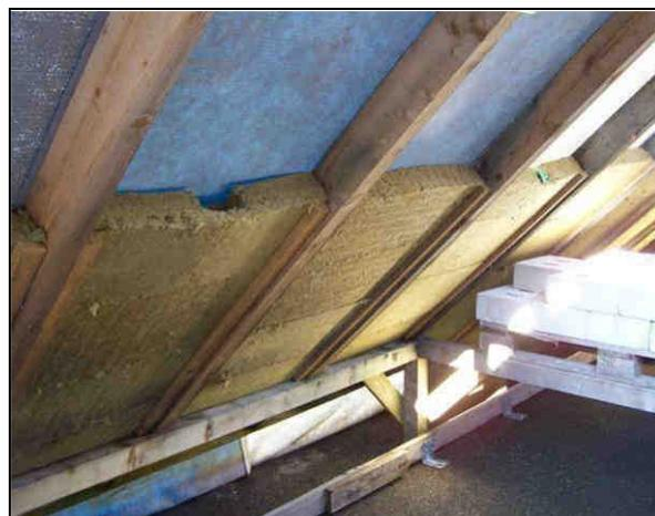
Abb. 25: Lage der Dämmung unter den Bahnen und Anordnung der Aussparung für die Datenlogger
