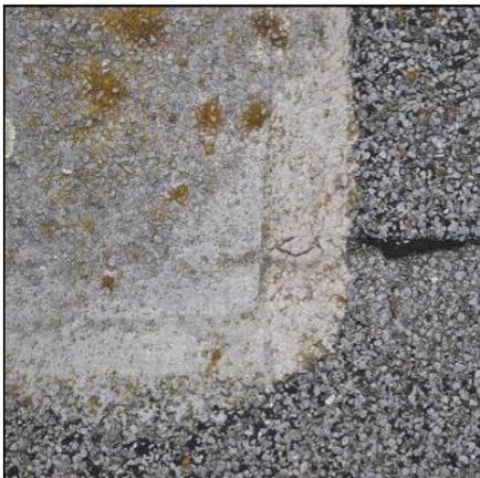
Bild 7-1: Schadensfrei gealterter Übergang
